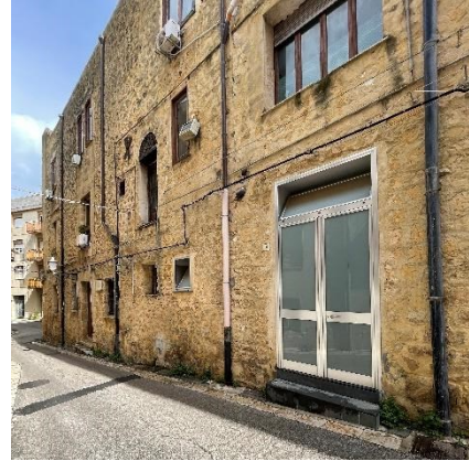
Figura 10 - Fronte ovest su Via Gagini
