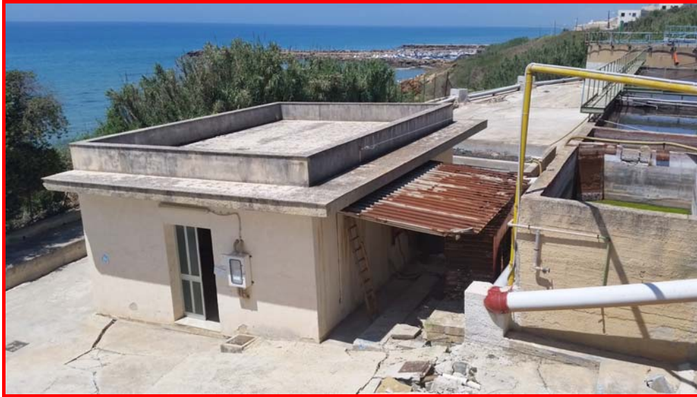
Figura 3 - Pavimentazione dell'impianto di MdS.
